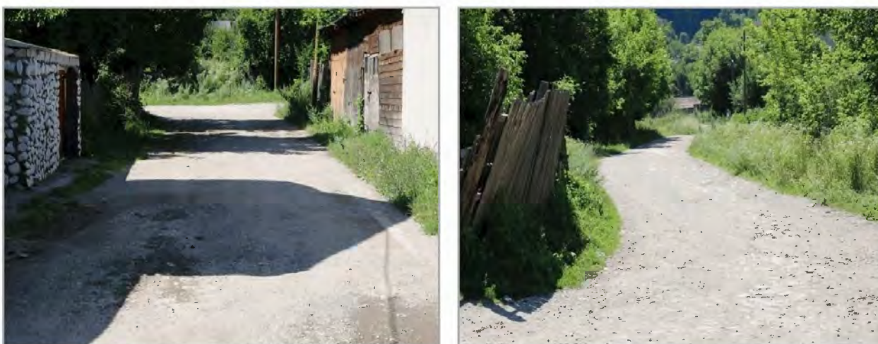
Figura 2.31. Străzi din pământ tasat și stabilizat în zona urbană Brezoi.
