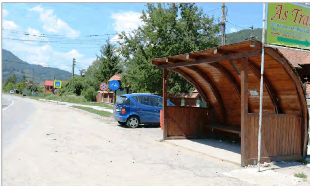
Figura 2.40. Stație de transport public local.
